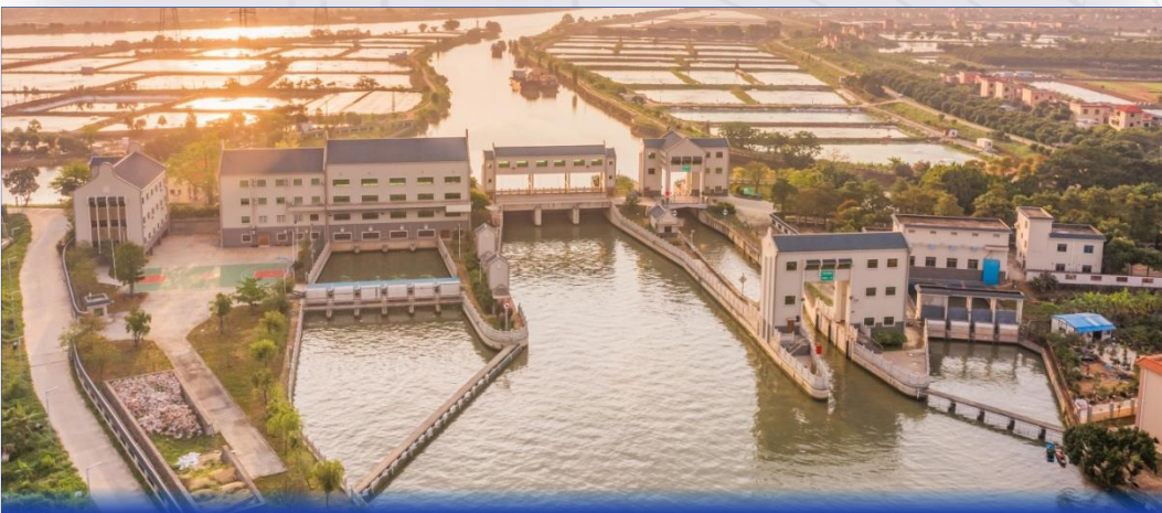
广东中山市阜沙镇鸦雀尾水利枢纽工程
