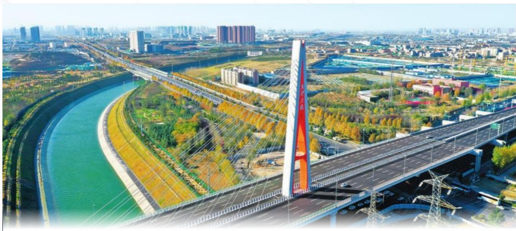
郑州市四环快速化工程
