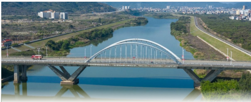
木兰溪防洪工程华林段 荣获2021-2022年度中国水利工程优质（大禹）奖
