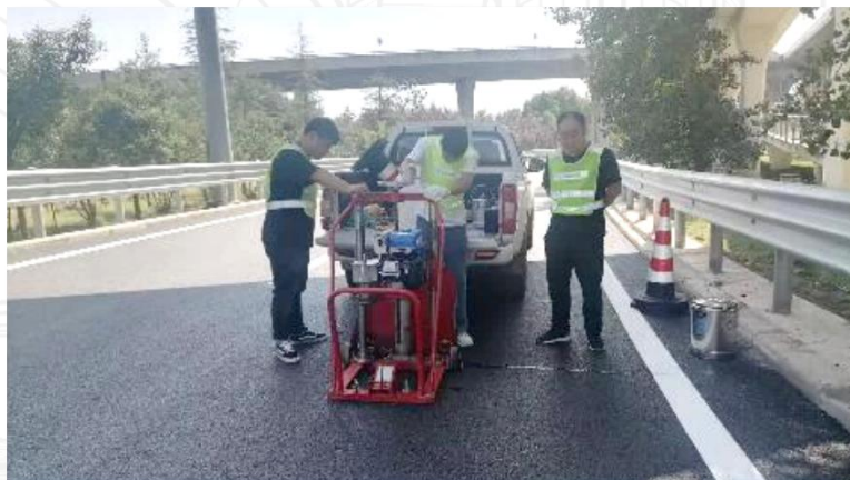
2022年郑州分公司路面修复养护工程施工XZLM-2 沥青路面芯样钻取自检
