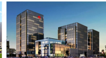
河南省交通规划勘察设计院有限责任公司 白沙分院三期
