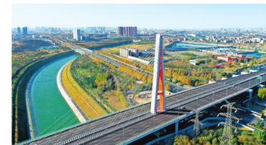
郑州市四环快速化工程
