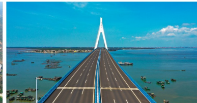
海南铺前大桥（海文大桥） 荣获2022-2023年度国家优质工程奖
